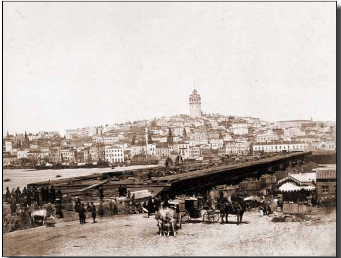
Galata Köprüsü inşaat halinde. Kargopulo 1875.
